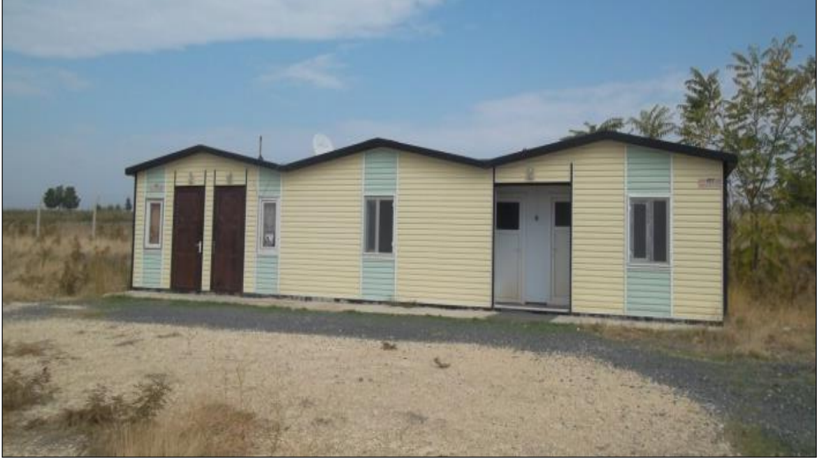
Şekil 19. İncelenen Taşınmazın Üzerindeki Büro Binasından Bir Görünüş
